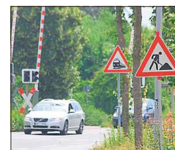
Der Bahnübergang Blumenstraße wird wegen Bauarbeiten ab heute für fast vier Wochen gesperrt. Bild: Wild
